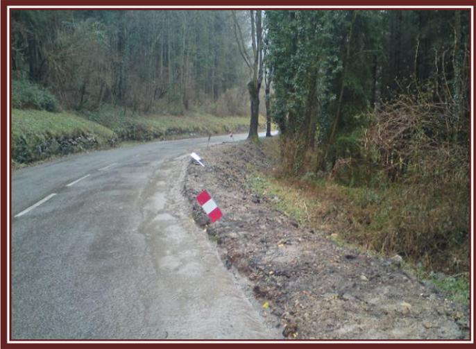
Les travaux sur la D618 ont consisté dans un premier temps à rehausser la chaussée côté village, afin d'empêcher l'eau de ruissellement de descendre directement sur les maisons. Une autre tranche de travaux sur le côté opposé devrait voir la pose de caniveaux pour guider l'eau de ruissellement jusqu'au Gouralet. Travaux prévus jusqu'en juin.
