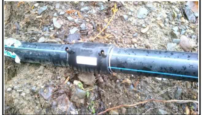
Un rouleau de 50M, de diamètre 63 m/m, est utilisé pour acheminer l'eau; la longueur totale de la conduite est 320 M. Les essais à 14 bars de pression ont permis de tester l'étanchéité
