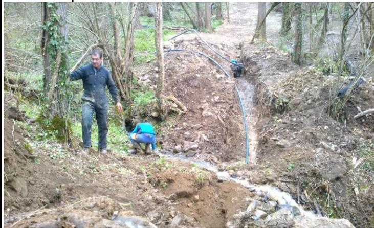
L'arrivée des deux tuyauteries avec la pose des deux vannes, une pour le château d'eau, l'autre pour l'alimentation de la cuve incendie
