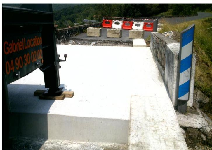
Merci au Conseil Général pour les travaux sur le pont du Goutet . Les dalles du tablier étaient fragilisées par le temps (un peu comme pour le pont du Couralet au milieu du village). Comme on peut le voir, une dalle en béton a été coulée, d'une épaisseur importante mais aussi en longueur puisque celle-ci débord d'un bon mètre de chaque côté du tablier. Ces travaux ont bloqué la route une dizaine de jours.
