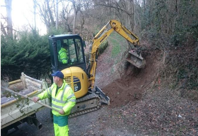
Le **SIVOM** a également mis en place un **exutoire** au bas du **Chemin de Saint-Roc** afin de canaliser les eaux de pluie.
