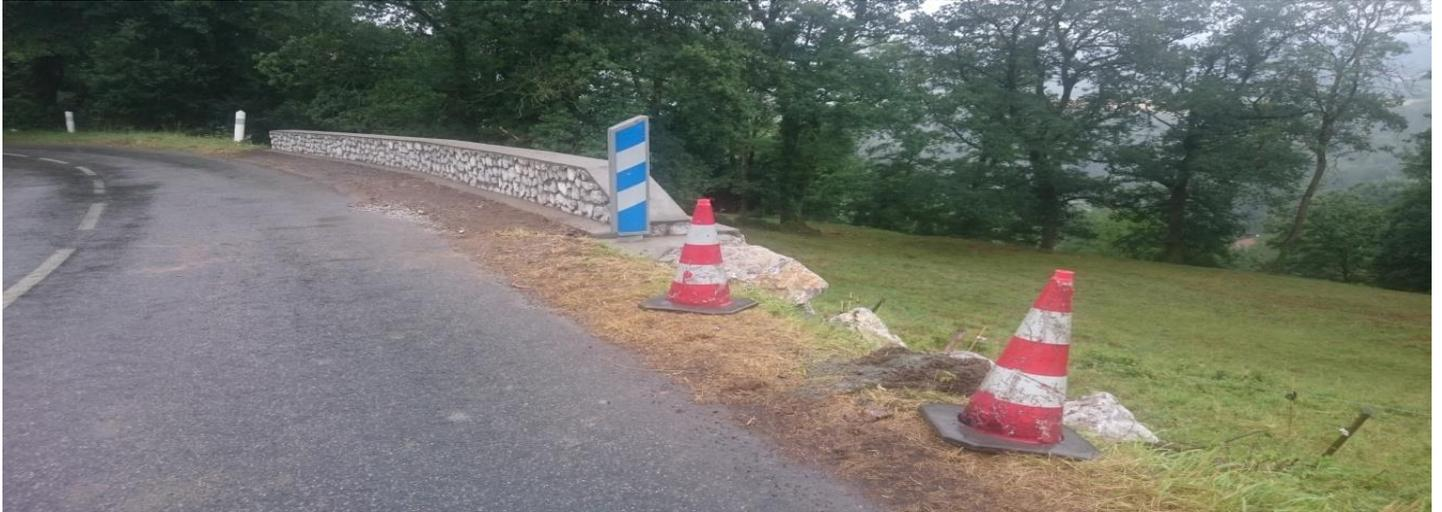
La DDT (Direction Départementale du Territoire) a réalisé un **mur de soutènement** sur la route du **Col des Ares** au niveau de la jonction avec le Chemin du Pujoulet. L'affaissement de la chaussée constaté en début d'hiver est mis en sécurité et les coureurs du tour de France pourront passer en toute tranquillité.
