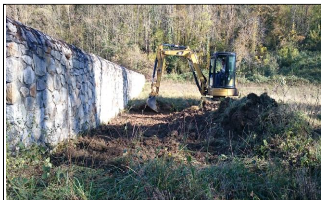
Début des travaux, mise à niveau du terrain
