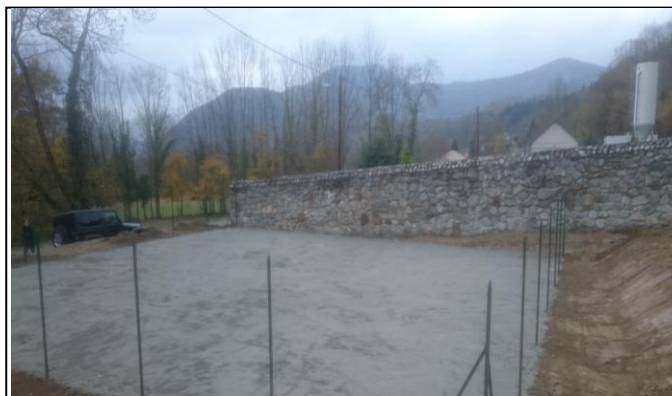
Le terrain est mis de niveau et recouvert de sable
