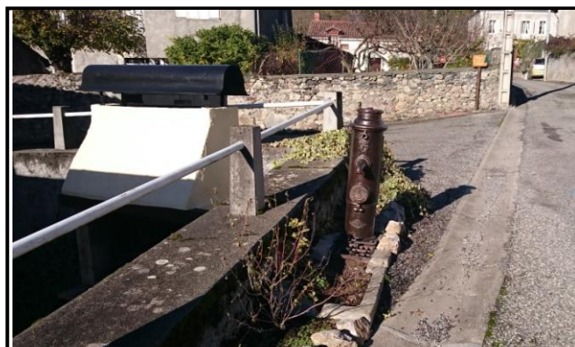
Décapage et couche d'antirouille des fontaines
